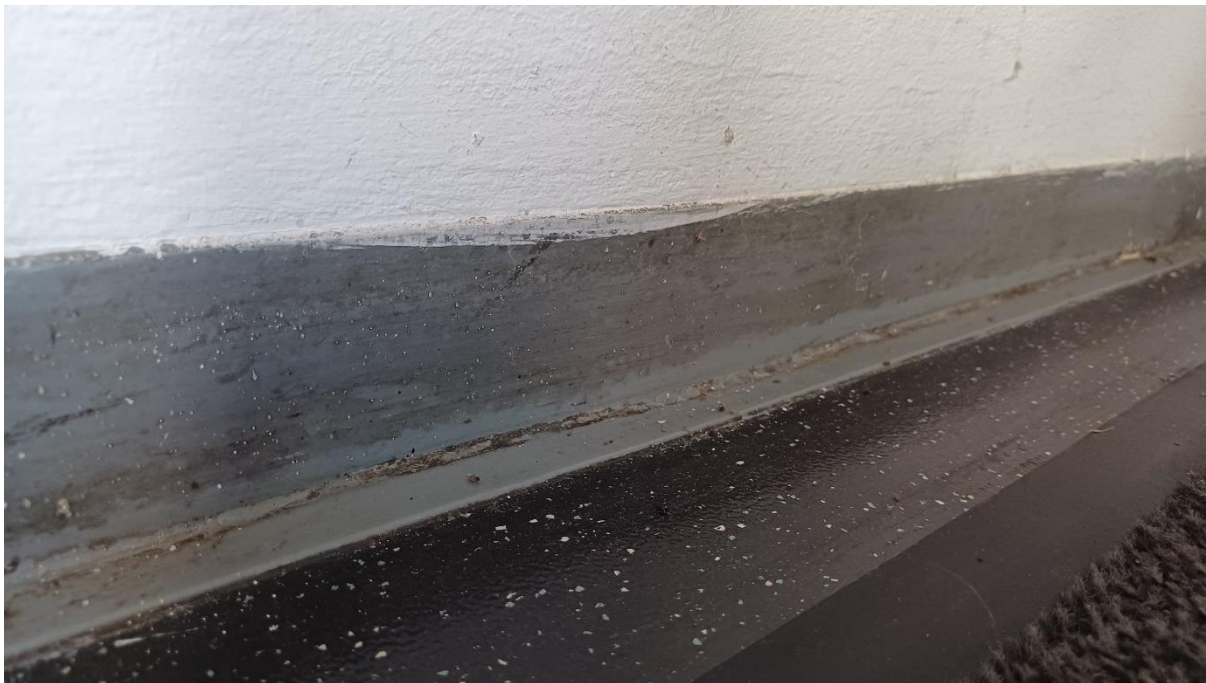
Zamazane obrobe z več nanosi starih premazov
